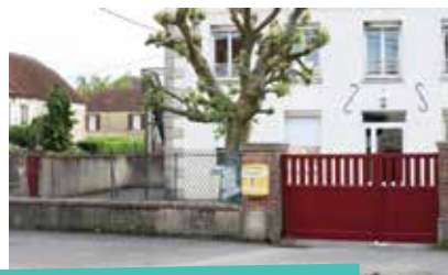
3 » remplacement du portail cour école élémentaire du Gault-Soigny
