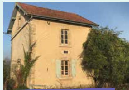
maison du garde-barrière à Villemoyenne
