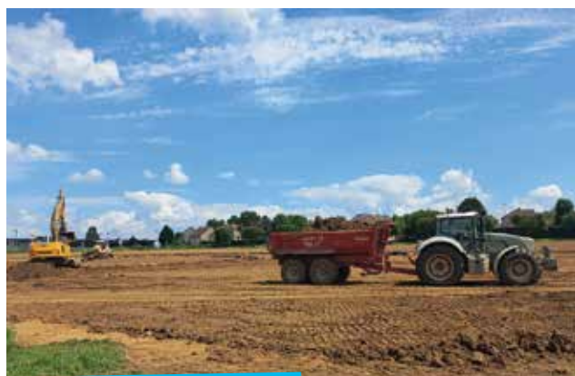
Les travaux ont commencé lundi 3 juin.
