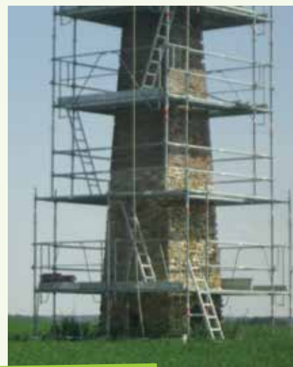
la tour de Champgillard pendant les travaux
