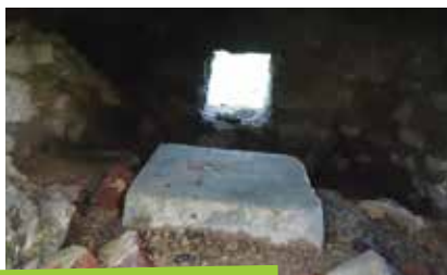
la pierre avec le petit trou pour vérifier l'aplomb du fil
