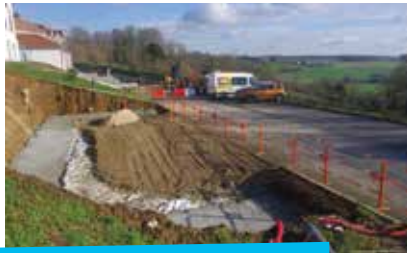
extension du parking du Pôle Santé
