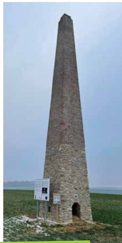
la tour de Champgillard à Tréfol (après les travaux)
