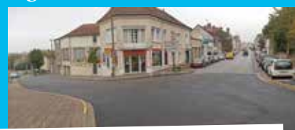
modification de priorité à l'intersection : avenue Charles de Gaulle - rue du Faubourg de Paris - rue du Docteur Philippe Amelin
