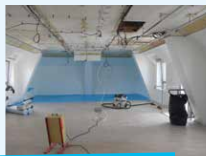
transformation de la salle de réunion en 4 bureaux au Pôle Santé
