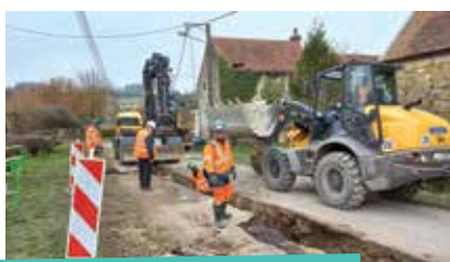
3 » travaux de remplacement AEP rue de la Liberté à Boissy-le-Repos
