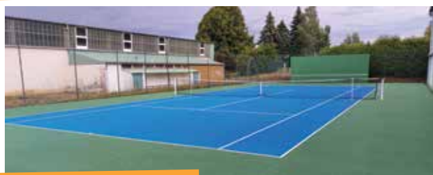
rénovation d'un court extérieur
