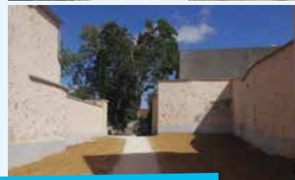
aménagement des remparts rue du Docteur Philippe Amelin
