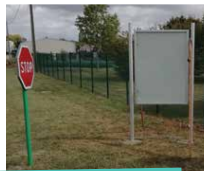
7 » pose d'une vitrine à la déchetterie de Montmirail
