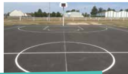
5 » réfection du terrain de basket à Montmirail
