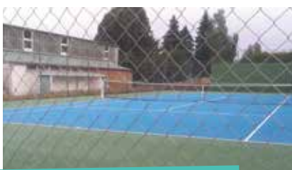
4 » rénovation des courts de tennis à Montmirail
