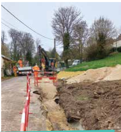
2 » extension du réseau d'assainissement collectif rue de la Folie à Montmirail
