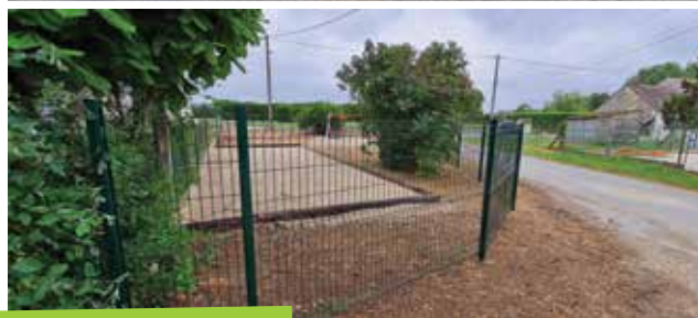
installation de l'aire de jeux
