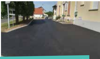
2 » travaux de voirie place de la Mairie au Vézier
