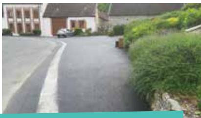
1 » travaux de voirie et d'eaux pluviales au Thoul-trosnay
