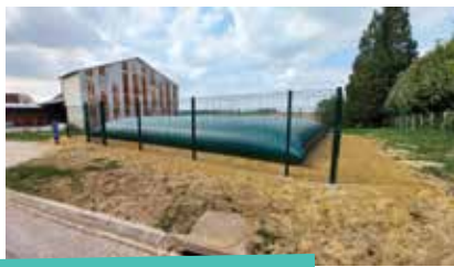
4 » installation d'une défense incendie hameau Le Recoude, commune du Gault-Soigny
