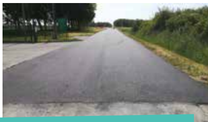
3 » travaux de voirie et élargissement de l'accès à la déchetterie de Maclaunay à Montmirail
