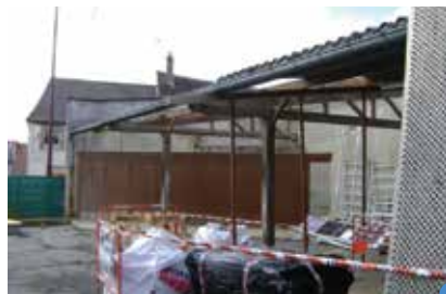
démolition du préau
