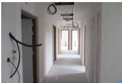
travaux en cours au Pôle Santé
