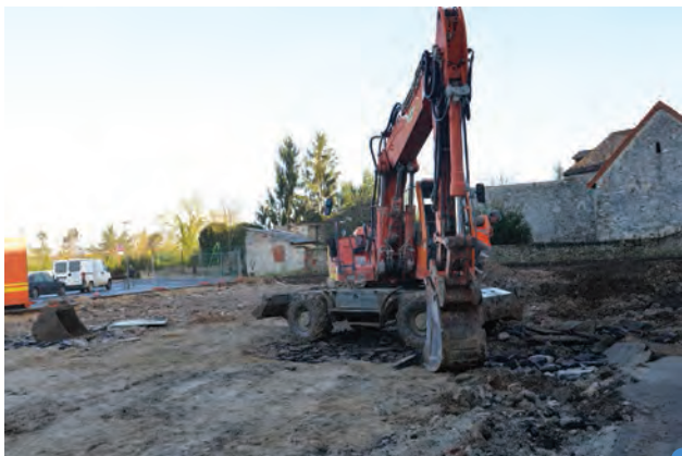
travaux pour le parking Impasse du Four
