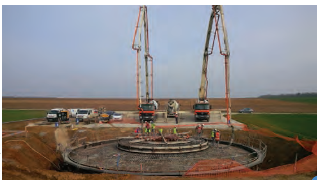
coulage du béton pour les fondations
