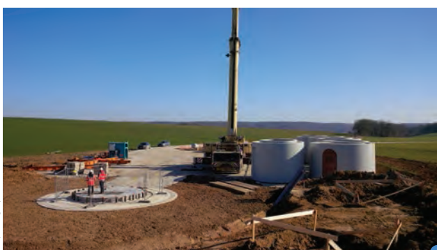
arrivée des premiers éléments des mâts, en béton
