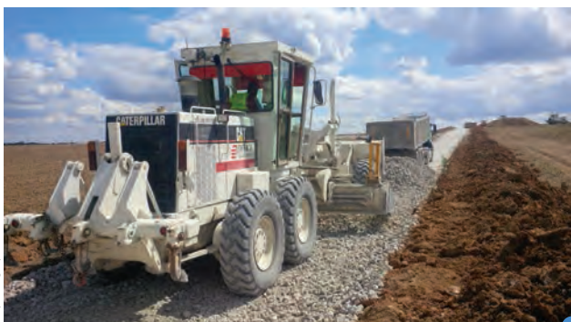
création des plateformes de montage et des voiries d'accès
