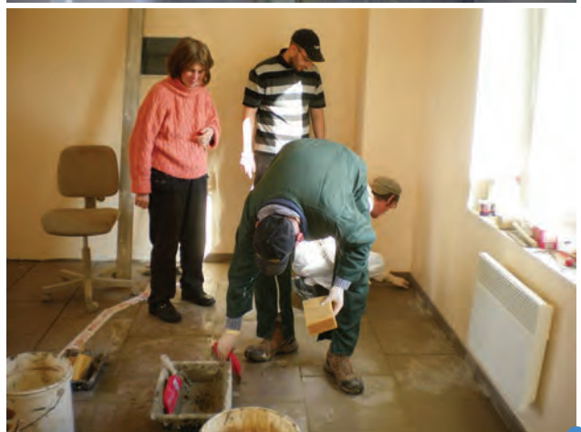
rénovation du local 2 bis rue de la Libération à Montmirail
