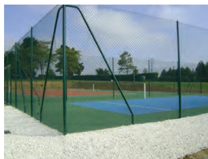
construction de deux courts de tennis à Montmirail
