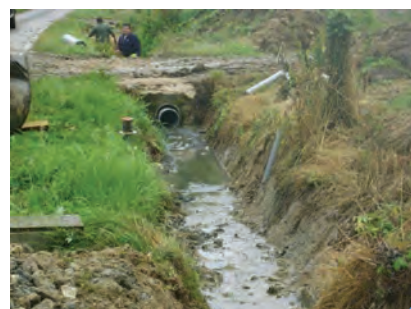
assainissement pluvial aux Rouillis (Tréfols)
