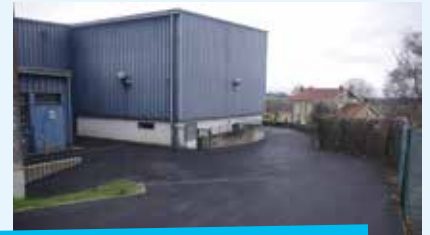
travaux de réfection de l'accès arrière de la salle Roger Perrin
