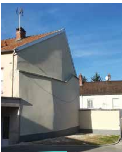
8» ravalement façade de l'ancienne cantine
