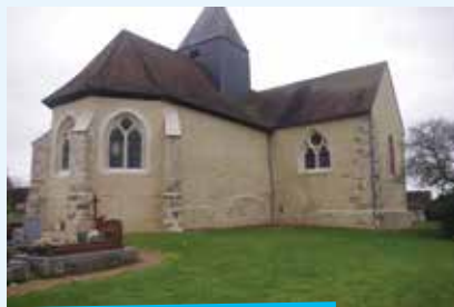
travaux de réfection sur l'église de l'Échelle-le-Franc
