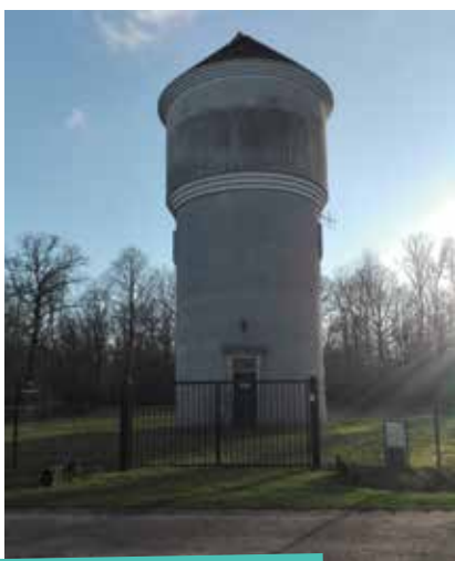
1 » pose de clôtures et portail au château d'eau de Verdon
