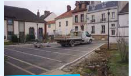
installation de bordures au Pôle Santé Montmirailais
