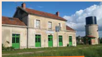
Rénovation de la gare de Montmirail /// TFBCO
