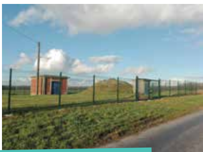
1 » pose de clôtures et portail à la réserve d'eau de Margny
