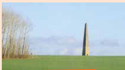
rénovation d'une tour géodésique /// Tréfols
