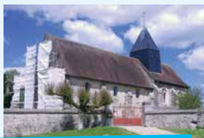
travaux sur l'église de L'Échelle-le-Franc
