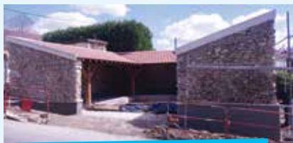
rénovation du lavoir de Fontaine-Essarts
