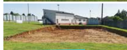
5 » travaux du boulodrome : terrassement en cours
