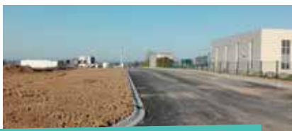
1 » Travaux ZI de Mondant à Montmirail
