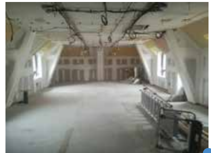
dernière phase de travaux à la Maison Médicale
