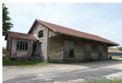
toiture neuve pour l'ancienne gare
