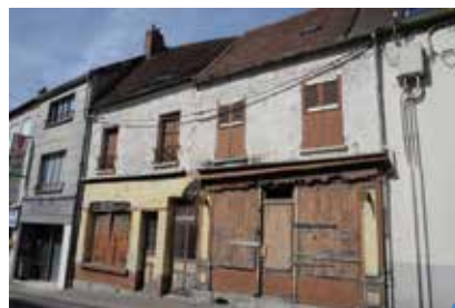
14/16 rue du Dr P. Amelin avant travaux
