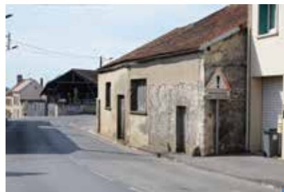
rue de la Croix Gaudé avant travaux
